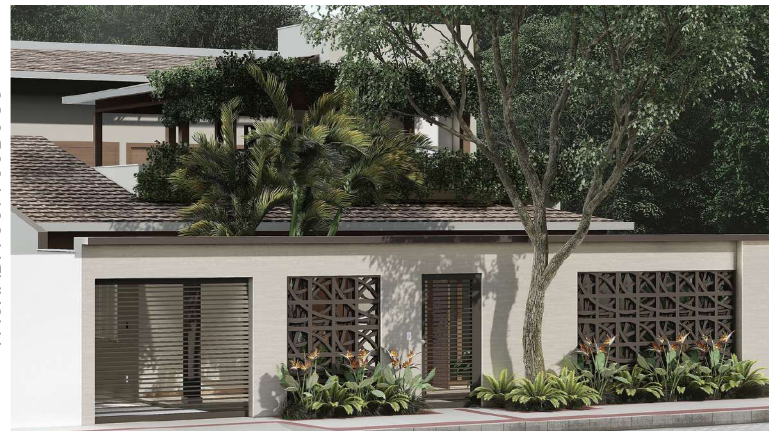
FACHADA COM COBOGÓ
